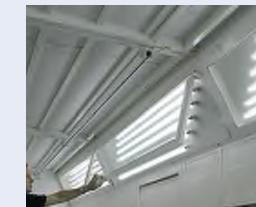
Plafoniers d'angle pivotants sur charnières pour faciliter le nettoyage et la maintenance.
