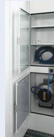
Casier équipé d'un enrouleur de tuyau avec corps en aluminium.
